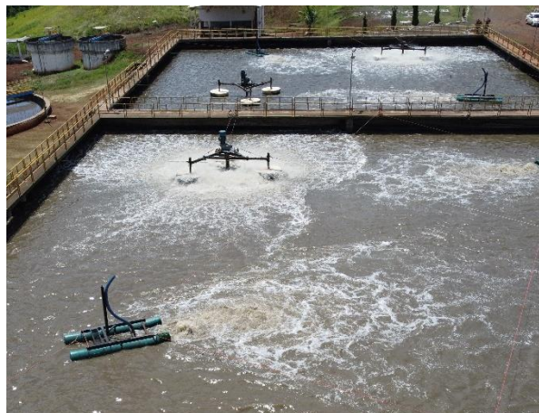
Figura 30 - Detalhe dos aeradores
