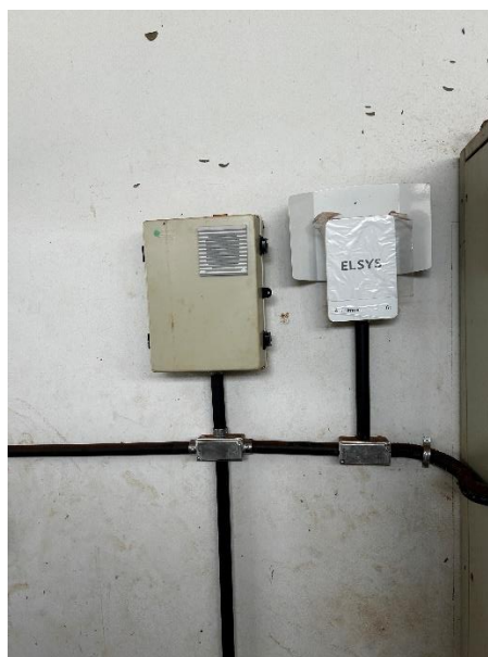
Figura 31 - Painel de Telemetria Sistema Garimpo
