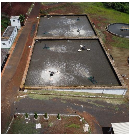
Figura 29 - Tanques de Aeração
