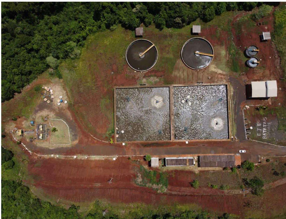
Figura 37 - Tanques de Aeração.
