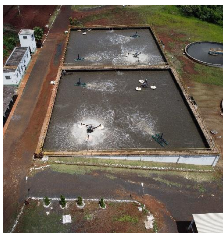
Figura 37 - Tanques de Aeração.
