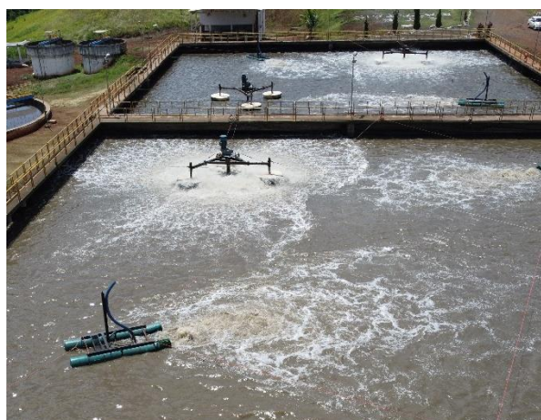
Figura 38 - Detalhe dos aeradores.
