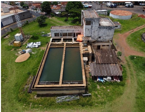
Figura 20 - Vista aérea dos decantadores.
