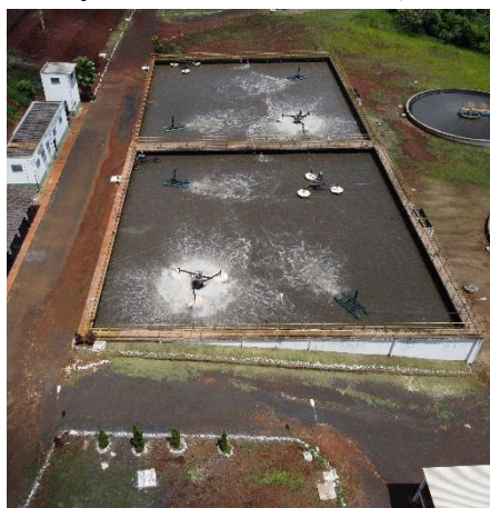
Figura 30 - Tanques de Aeração.
