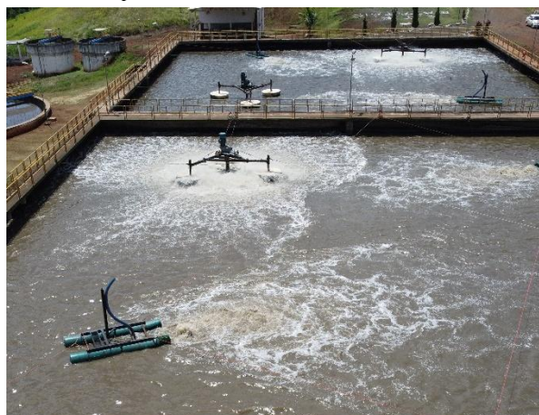
Figura 31 - Detalhe dos aeradores.
