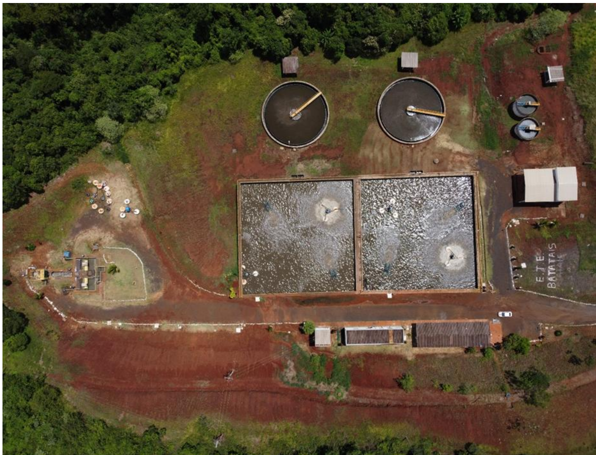
Figura 30 - Tanques de Aeração.
