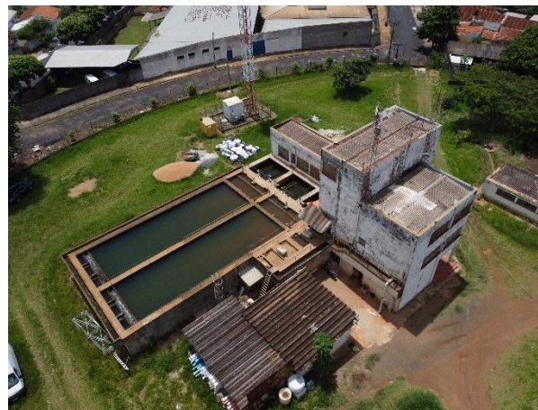
Figura 21 - Vista lateral da ETA.
