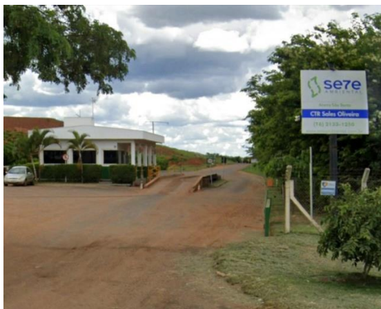
Figura 37 - Vista do acesso ao aterro sanitário
