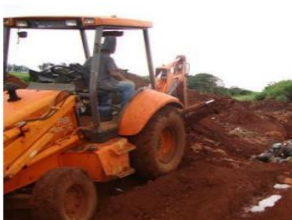
Figura 38 - Aterro sanitário antes da cobertura do resíduo depositado no dia.
