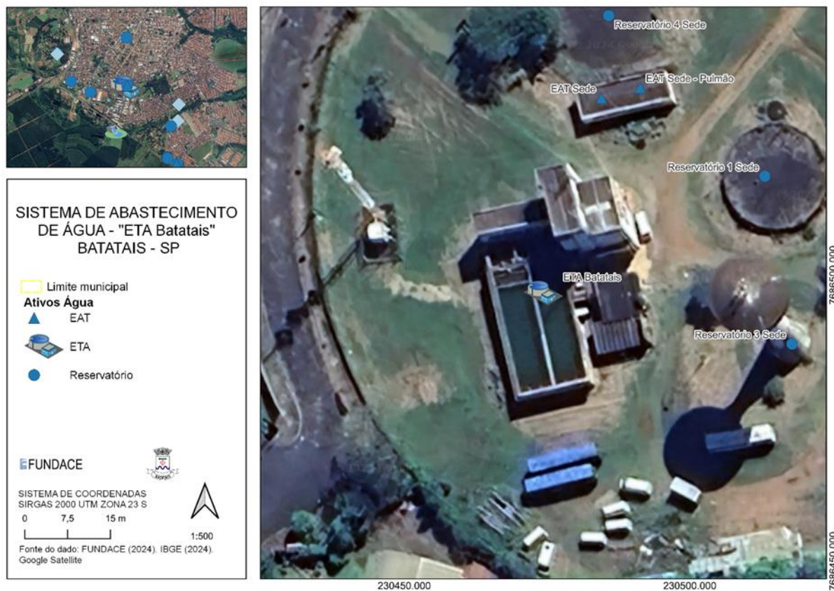
Figura 18 - Estação de Tratamento de Água de Batatais/SP.
