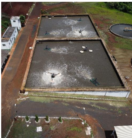
Figura 30 - Tanques de Aeração.
